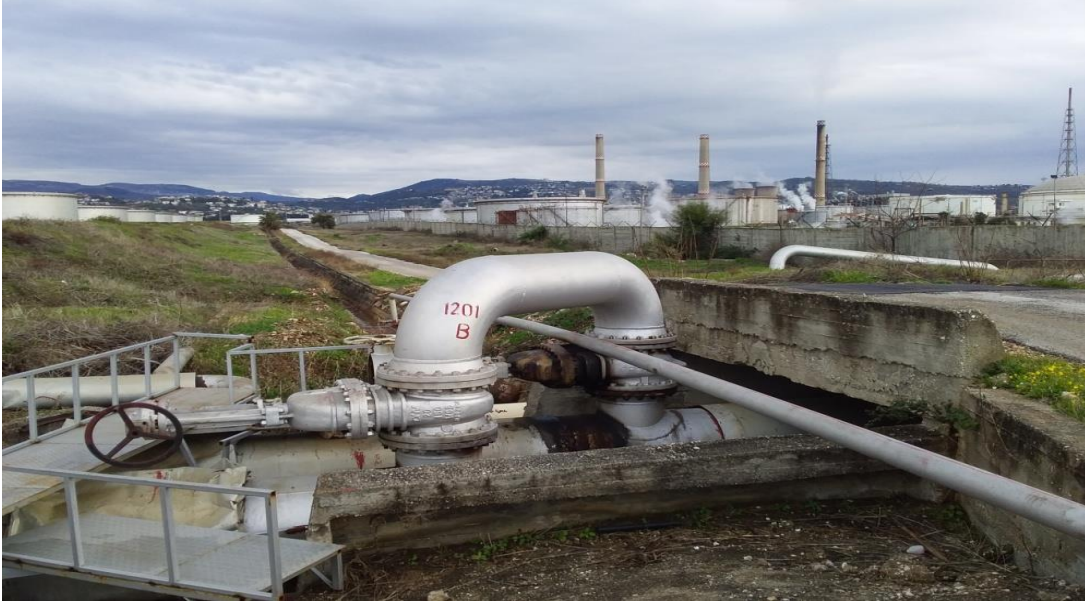
منطقة a point والسواقي المطرية للخزانات قبل تصريفها الى الساقية المطرية للمصفاة تخضع لمراقبة دائمة
