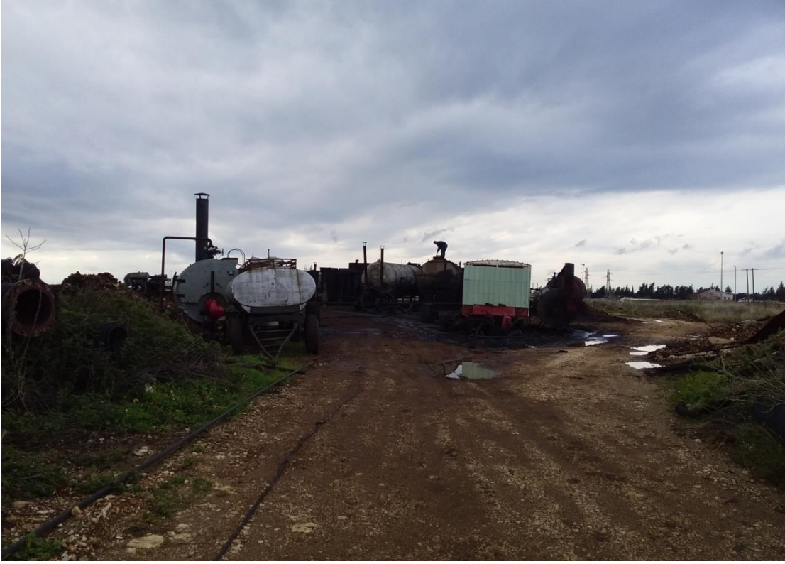
معدات وتجهيزات مشروع معالجة الرواسب النفطية
